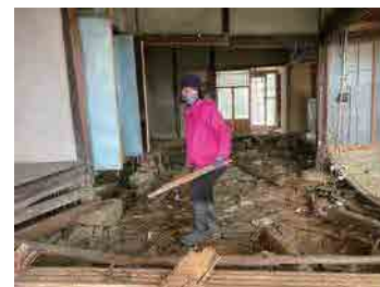
古民家のゴミ出し / 改修
