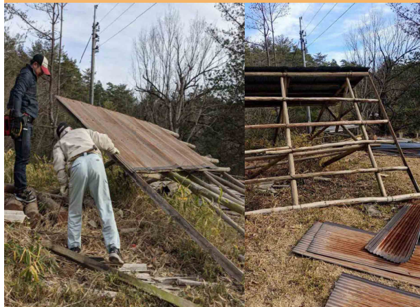
炭焼小屋の解体
