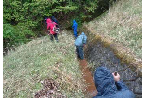
水路の泥上げ作業
