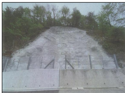
道路法面崩落防止工事
