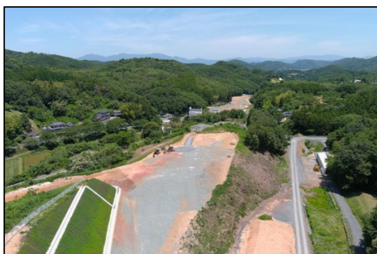
英田 IC 付近の工事風景
