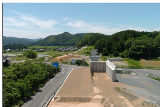
湯郷温泉 IC 付近の工事風景
