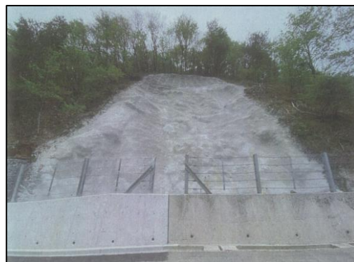
道路法面崩落防止工事
