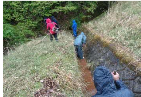
水路の泥上げ作業
