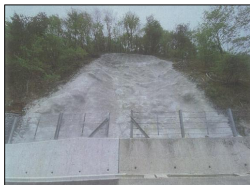
道路法面崩落防止工事
