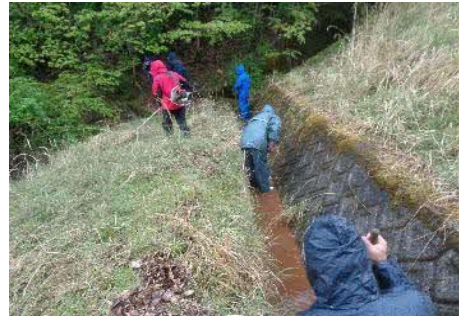
水路の泥上げ作業
