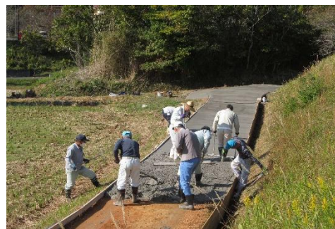
農道整備作業
