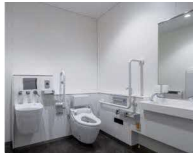
多目的トイレ
