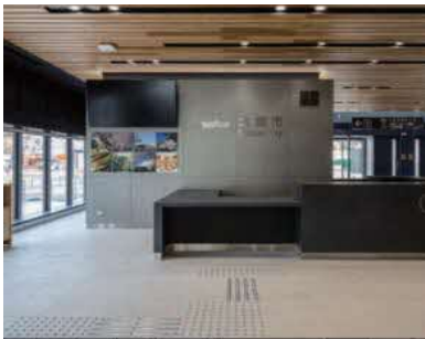
誘導ブロック
