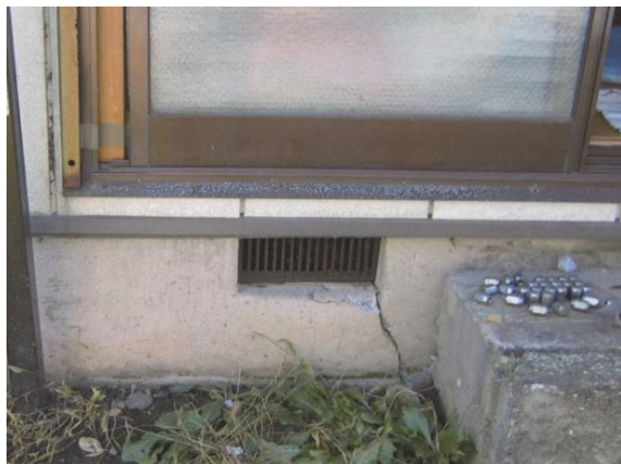
例3）基礎の一部にひび割れが生じた。
