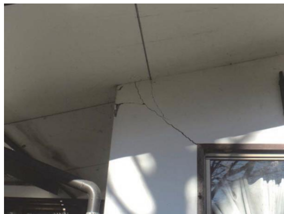
例2）外壁の一部にひびが生じた
