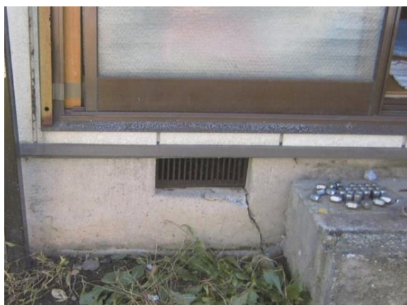
例3）基礎の一部にひび割れが生じた。
