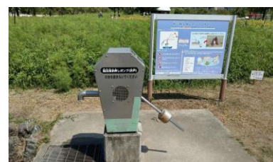
防災井戸 手押しポンプ
