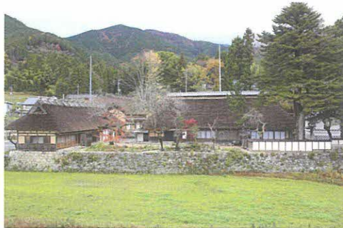
写真19 修理工事が終了した林家住宅【国】
