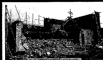
旧土居公民館解体工事
