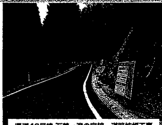
県道46号線 万善一海の宮線 道路拡幅工事
