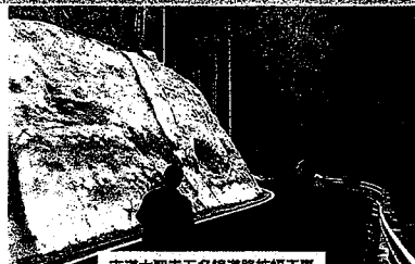
市道大聖寺五名線道路拡幅工事
