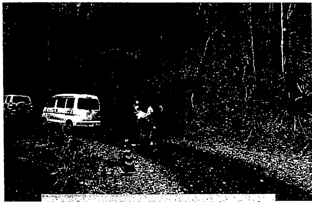
市道大聖寺東五名線拡幅工事
