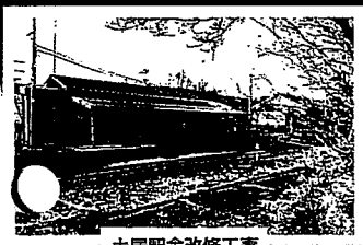
土居駅舎改修工事
