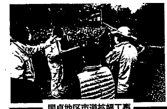
国貞地区市道拡幅工事
