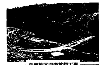
角南地区県道拡幅工事
