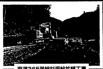
県道365号線杉坂峠拡幅工事
