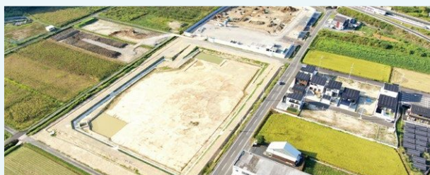
▲工事状況写真 (9月下旬)
