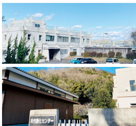
▲美作浄水場(上)、美作浄化センター(下)
