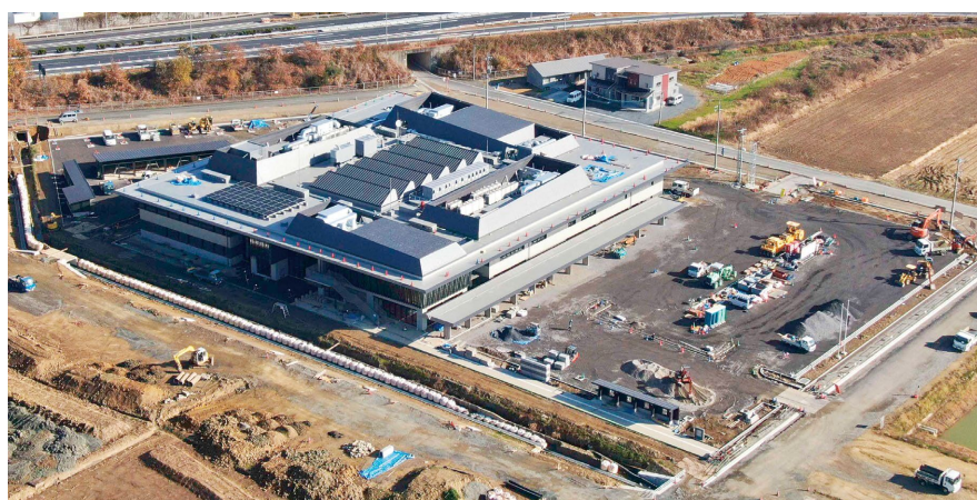
▲工事状況写真(12月中旬)
