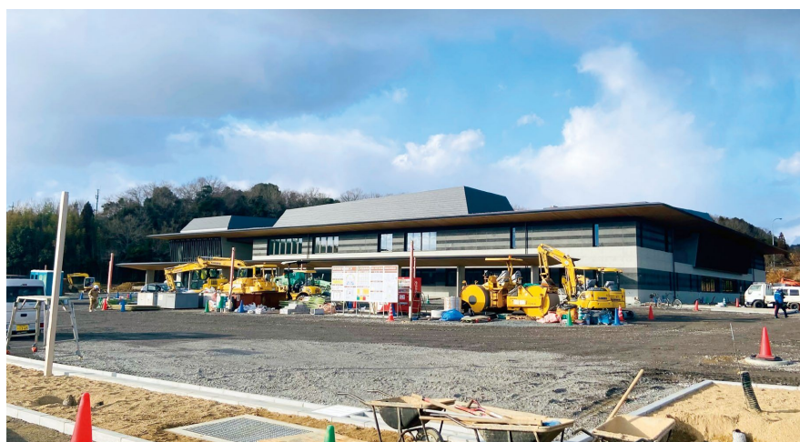
▲工事状況写真(1月上旬)
