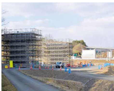
美作岡山道工事建設現場
