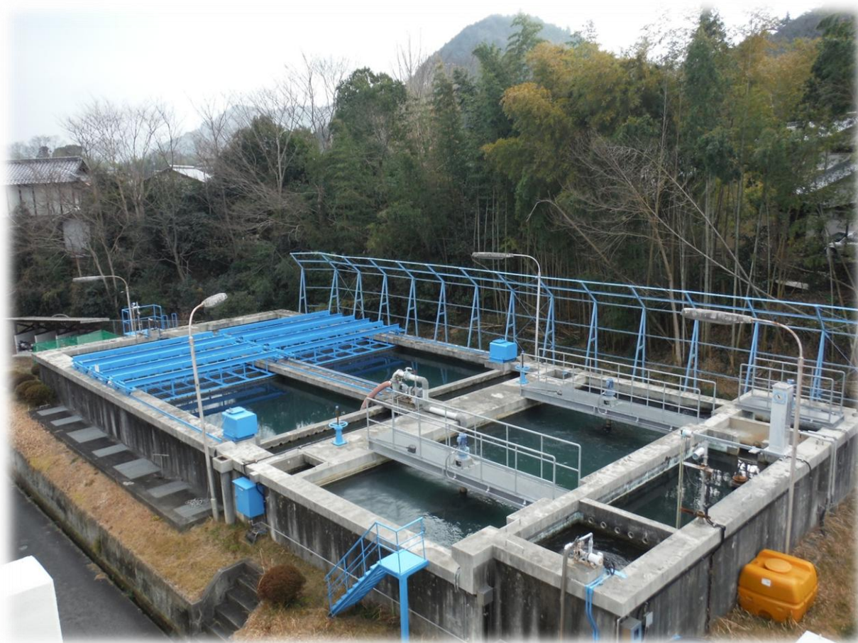
美作浄水場(沈澱地)
