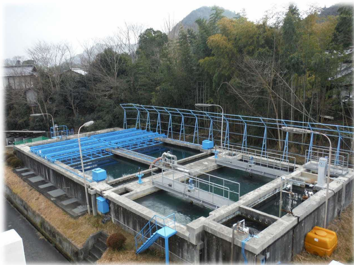
美作浄水場(沈澱地)
