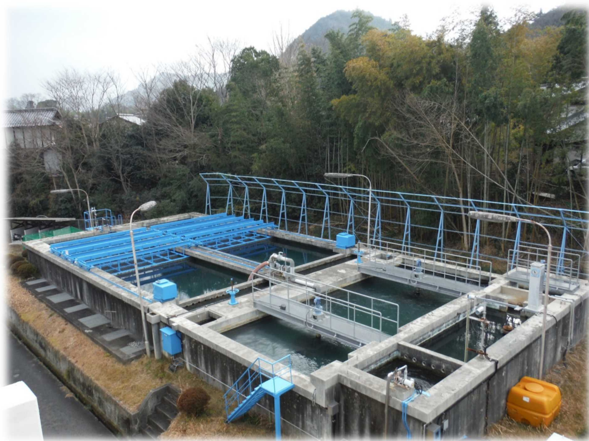
美作浄水場(沈澱地)
