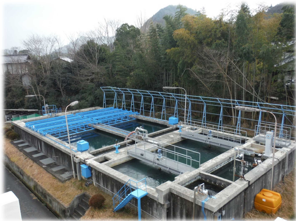
美作浄水場(沈澱地)
