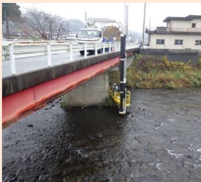
橋梁点検車による点検
