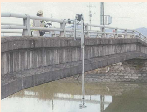
ロボットカメラによる点検
