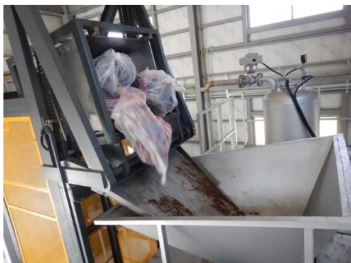
反転投入機による投入
