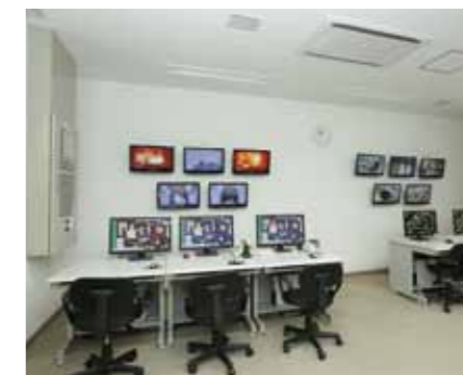
中央制御室 プラント設備全体の運転状況を集中監視および制御をしています。各設備はコンピュータシステムにより自動運転されています。
