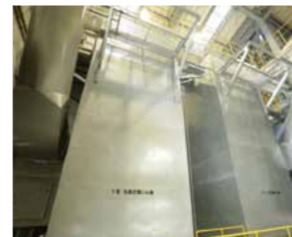
ろ過式集じん器 排ガスの中に含まれる有害なものを取り除き、クリーンな状態にします。
