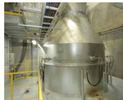
ガス冷却室 高温の燃焼ガスを自動制御の水噴霧により、急速に冷却します。
