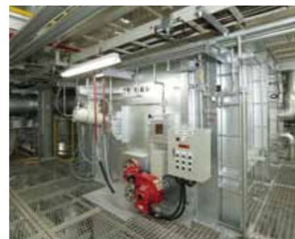
焼却炉 様々なごみ質に対応してそれぞれのごみ送り速度と燃焼用空気の吹き込み量を調節することで、850℃の高温で焼却を行い、ダイオキシン類の発生を抑制します。
