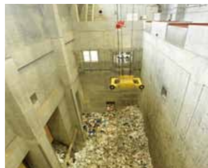
ごみクレーン・ごみピット ごみピットに貯められたごみは攪拌された後、ごみクレーンにてごみ投入ホッパへ投入します。
