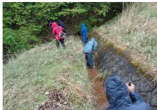
水路の泥上げ
