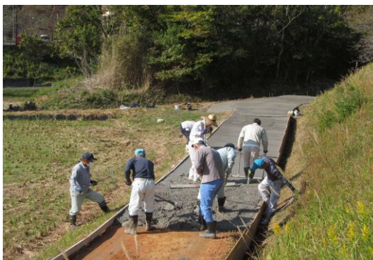
未舗装農道の舗装
