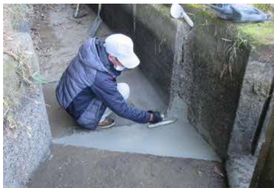
ひび割れの補修
