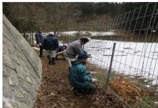
防護柵の維持管理作業
