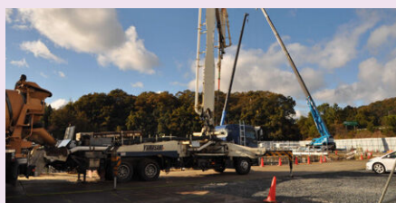
▲工事状況写真(11月中旬)
