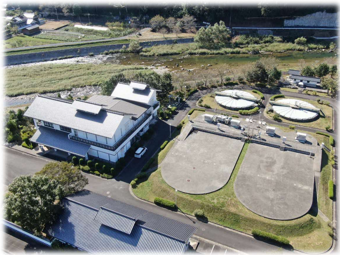
大原浄化センター 平成12年10月1日供用開始
