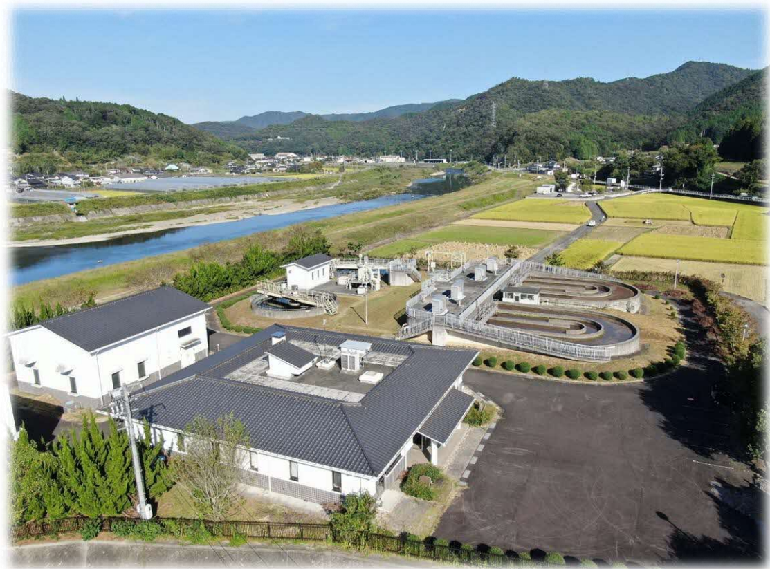
英田浄化センター 平成 13 年 3 月 30 日供用開始
