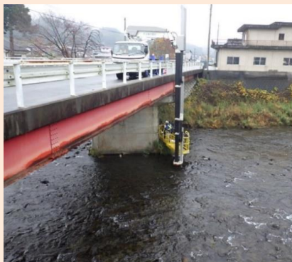
橋梁点検車による点検
